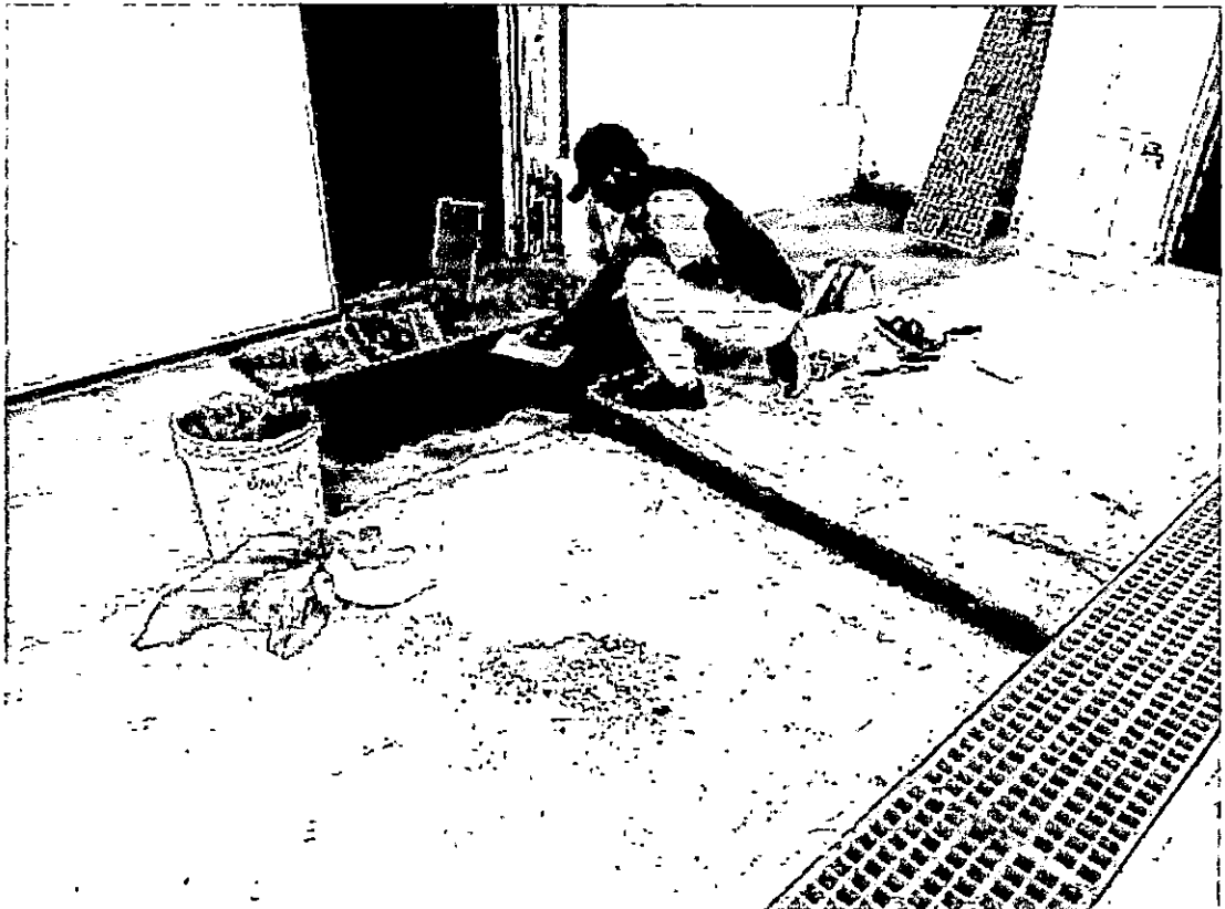
Fotografía N°09: Vista de personal operario realizando instalación de rejilla frente a cámara frigorífica de 5 ton.
