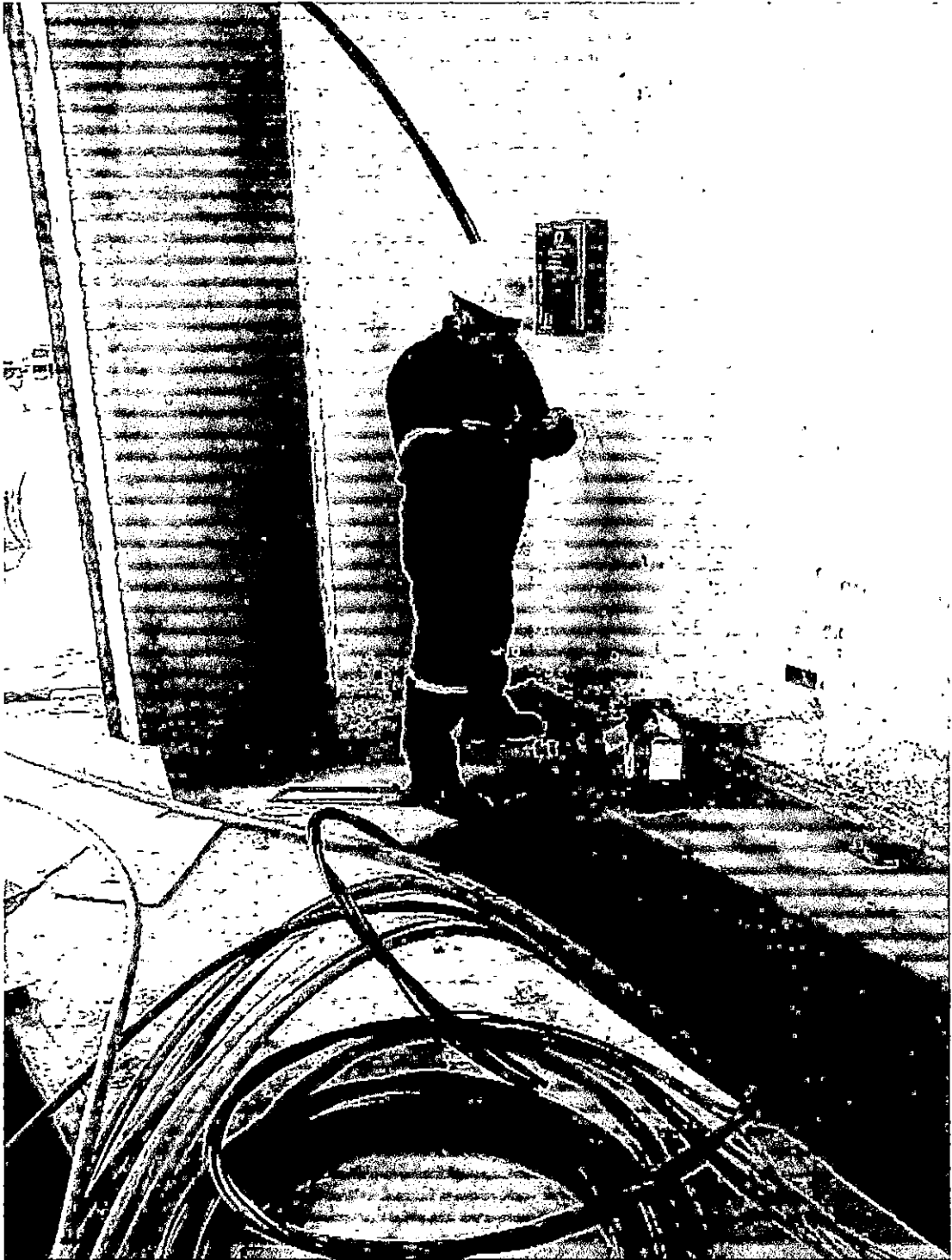
Fotografía N°13: Vista de personal realizando cableados eléctricos.
